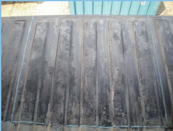
3. 表面处理完成后，喷涂防锈转化底漆
