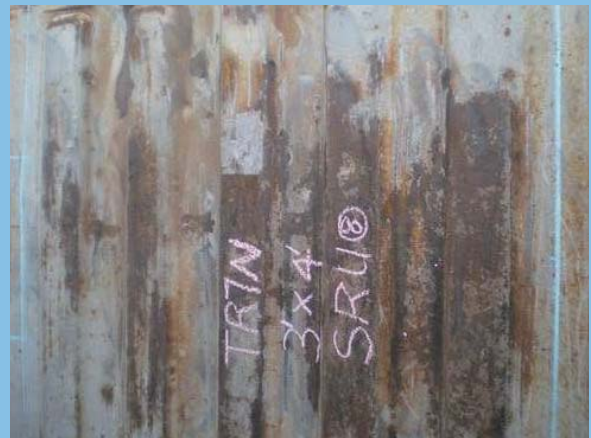
2. 用磨机清除表面的浮锈
